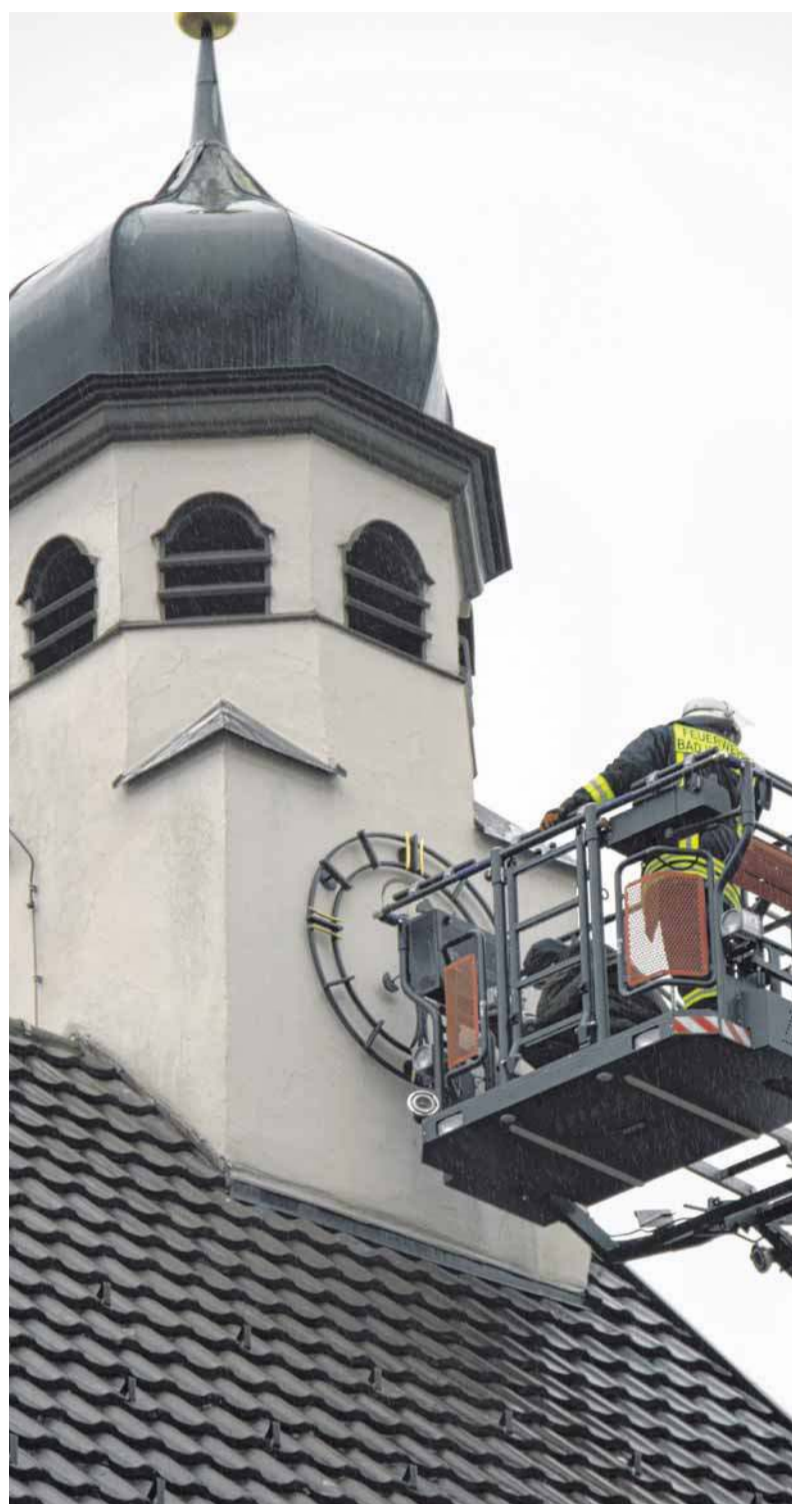
Einsatz in luftiger Höhe: Martin Westermayer (links) und Rolf Butscher montieren die Zeiger der Rathausuhr ab. FOTO: LUCAS OSSWALD
